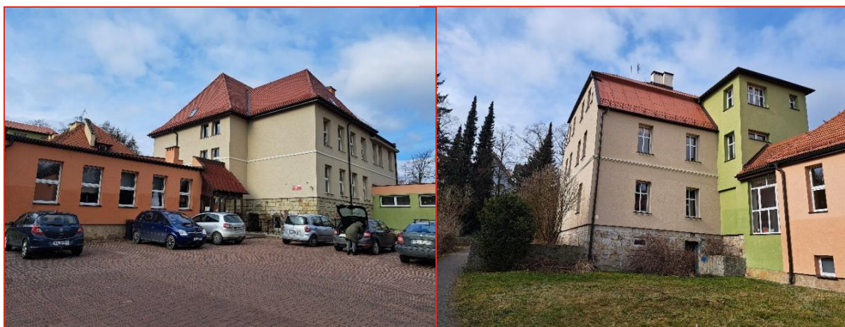
Rysunek 20. Budynek dawnego gimnazjum przy ul. Zdrojowej
